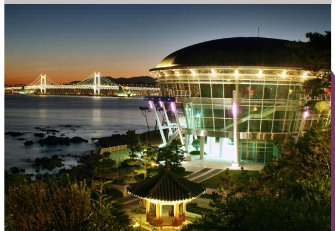
Nurimaru APEC House, Busan, Corée du Sud. Nurimari APEC House, Busan, Corée du Sud.
